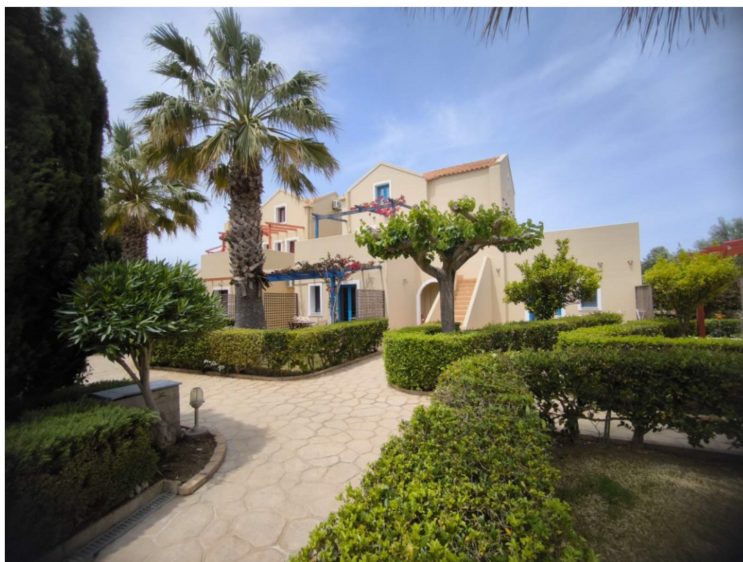
Φωτογραφία 9: ΚΤΙΡΙΟ Η-Θ
