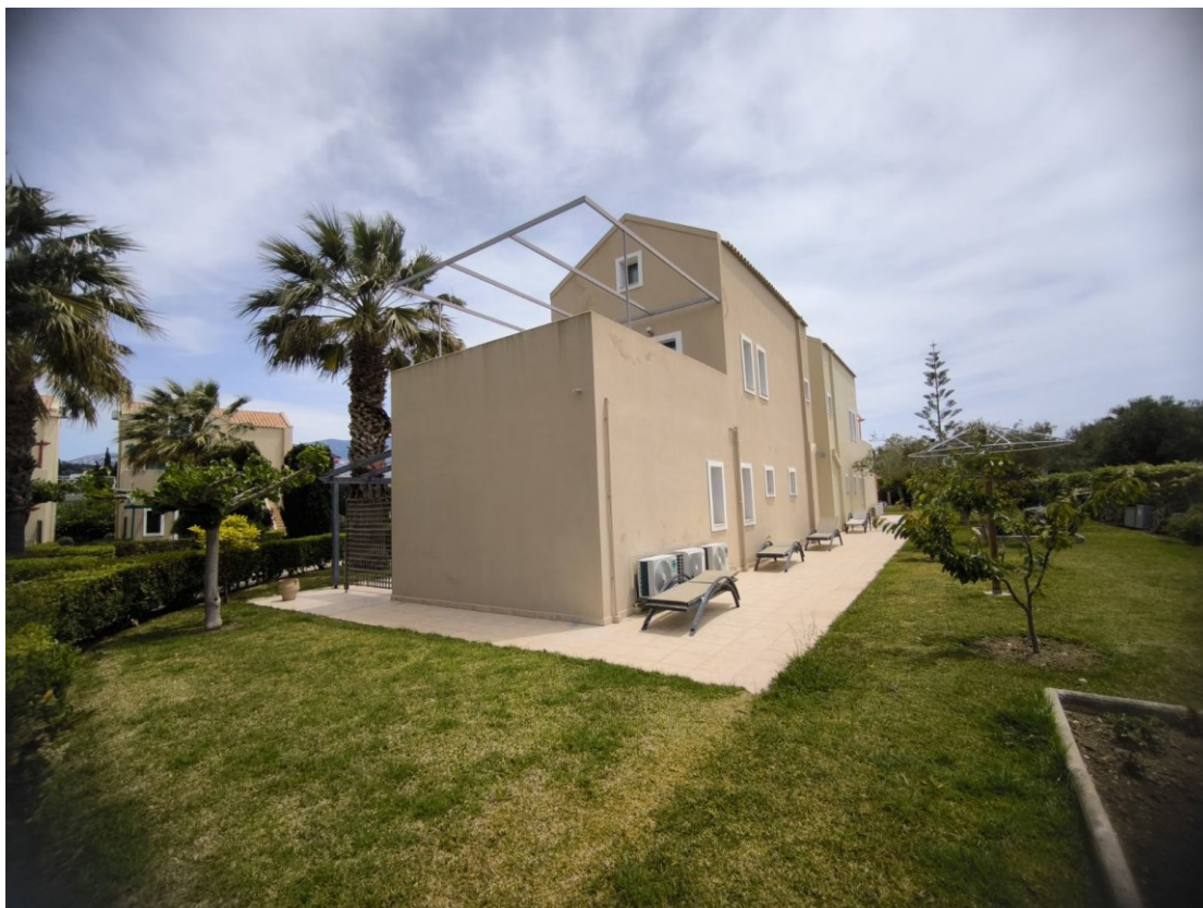
Φωτογραφία 8: ΚΤΙΡΙΟ Η-Θ
