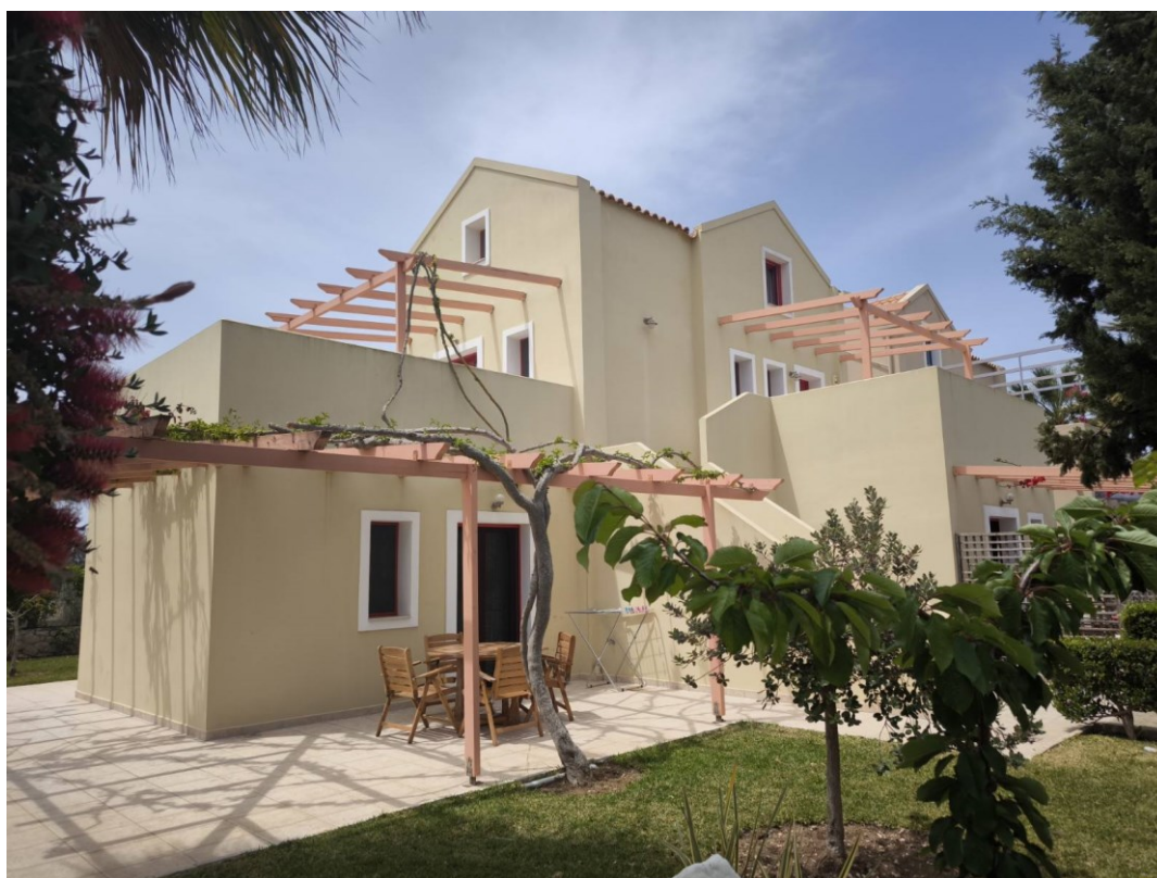
Φωτογραφία 5: ΚΤΙΡΙΟ Η-Θ
