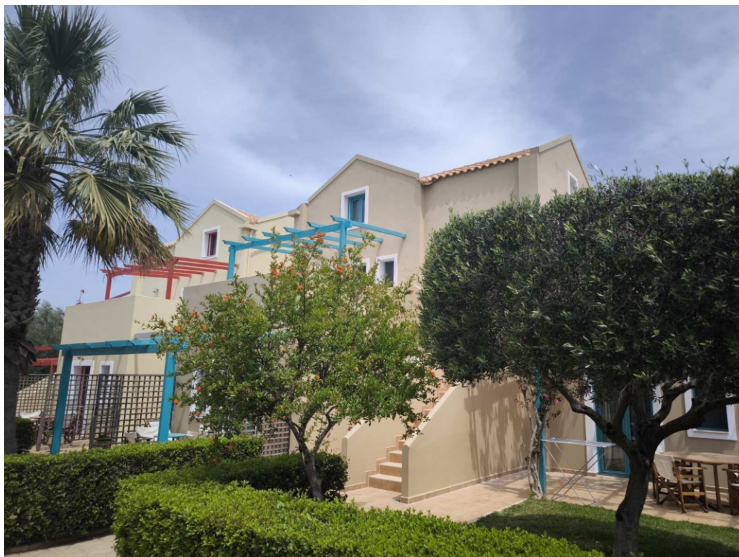
Φωτογραφία 7: ΚΤΙΡΙΟ Γ-Δ
