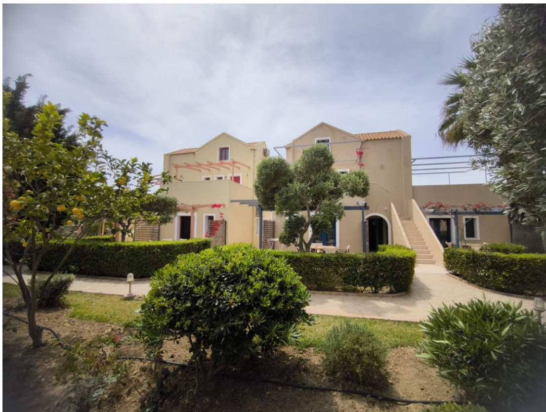
Φωτογραφία 6: ΚΤΙΡΙΟ Η-Θ
