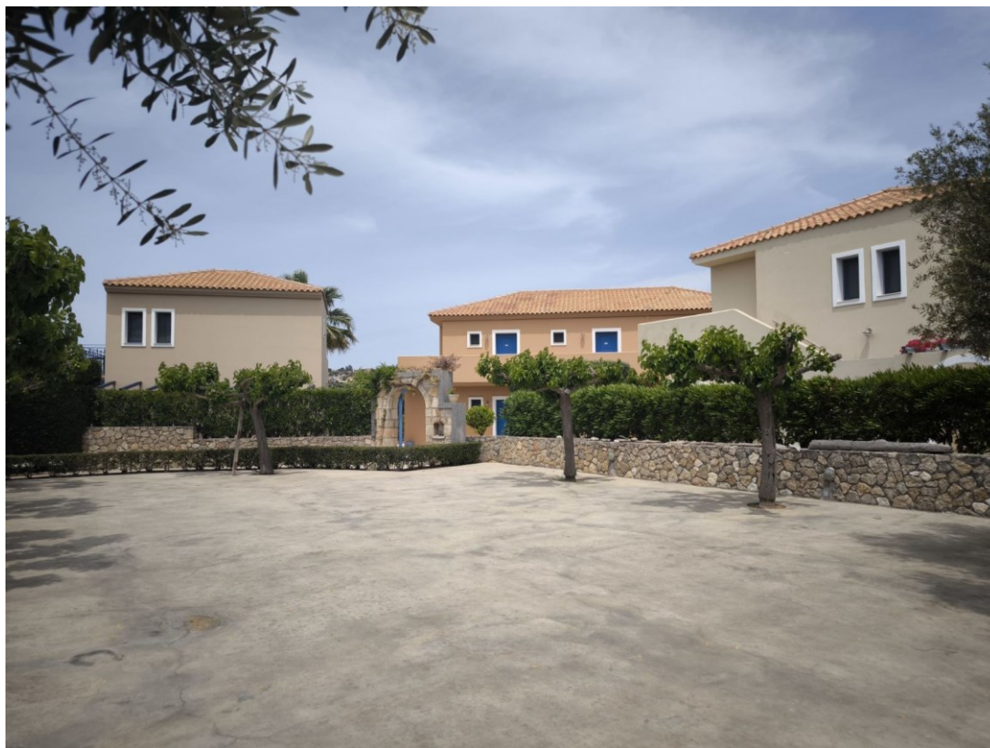
Φωτογραφία 19: ΚΤΙΡΙΟ 2Δ , ΚΤΙΡΙΟ 2Ε ΚΑΙ ΚΤΙΡΙΟ 5
