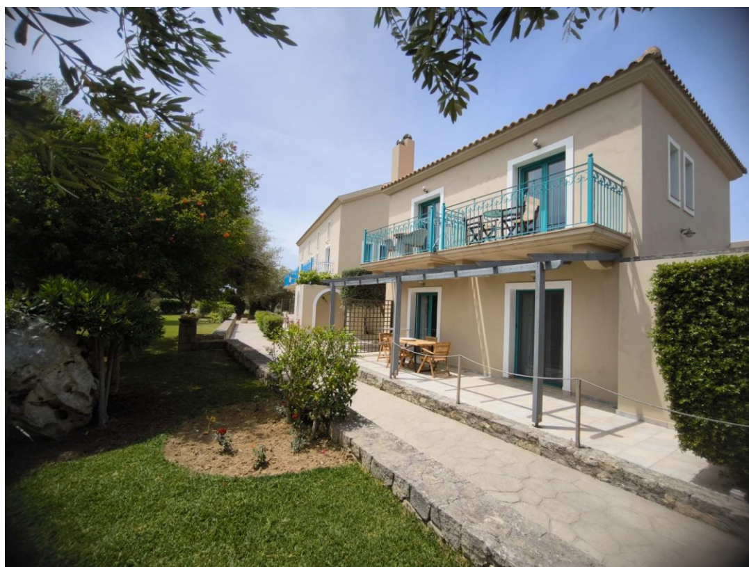
Φωτογραφία 13: ΚΤΙΡΙΟ 4 ΚΑΙ ΚΤΙΡΙΟ 2Α
