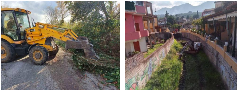
Εικόνες 1.1.14, 1.1.15: Εκτεταμένοι καθαρισμοί ρεμάτων και αντιπλημμυρικές παρεμβάσεις στην Κέρκυρα
