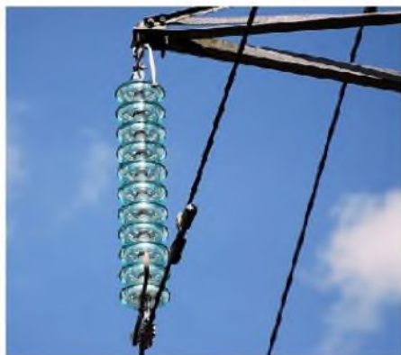
Εικόνα 6.1-10: Άποψη μονωτήρα σε εναέριας Γραμμής Μεταφοράς
