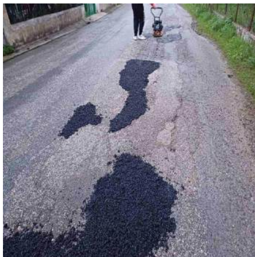
Εργασίες επουλώσεως λακκουβών στο σύνολο της επικράτειας της Κέρκυρας.
