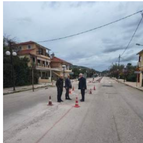
Κατασκευή νησίδων ασφαλείας, Νικιάνα Λευκάδας
