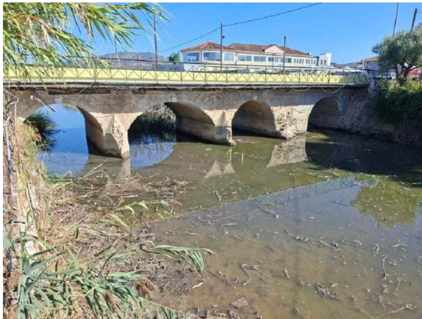
Αντιπλημμυρικές παρεμβάσεις στο υδρογραφικό δίκτυο της Π.Ε. Ζακύνθου, στην περιοχή Ξιφίτα, με εργασίες βελτίωσης της απορροής και ενίσχυσης της προστασίας οικισμών και υποδομών.
