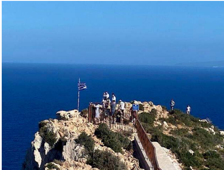
Περίφραξη χώρου Ναυαγίου (Α΄ φάση), Ζάκυνθος.
