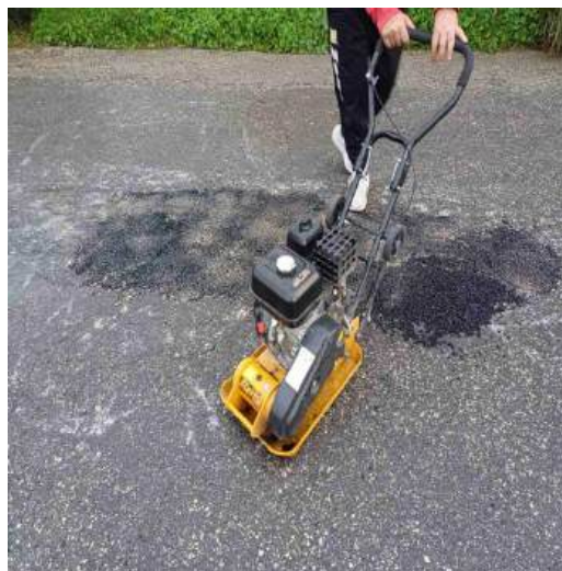
Εργασίες επουλώσεως λακκουβών στο σύνολο της επικράτειας της Κέρκυρας.
