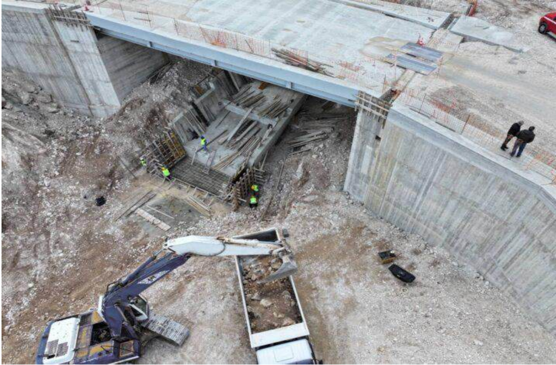
Αυτοψία του Περιφερειάρχη Ιονίων Νήσων στο έργο κατασκευής της γέφυρας του Χειμωνικού στην Κεφαλονιά, στο πλαίσιο παρακολούθησης της πορείας υλοποίησης του έργου.
