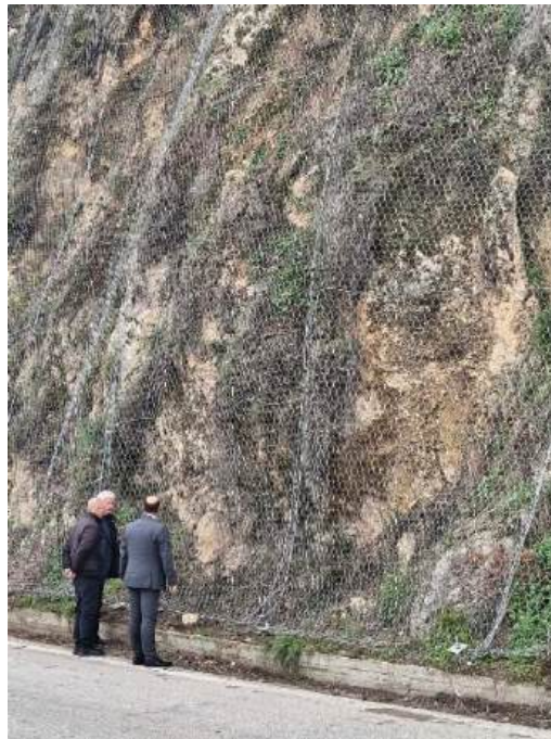
Εργασίες ενίσχυσης και αποκατάστασης βραχοπαγίδων.
