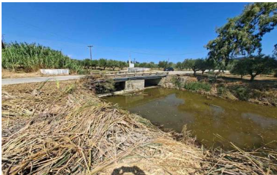
Εργασίες εκβάθυνσης και καθαρισμού στη θέση «Παλιοκαμάρα», επί της επαρχιακής οδού Ζακύνθου–Ρομιρίου, με στόχο τη βελτίωση της απορροής υδάτων και την πρόληψη πλημμυρικών φαινομένων.
