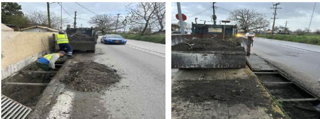
Καθαρισμοί φρεατίων και τεχνικών υποδομών απορροής ομβρίων.
