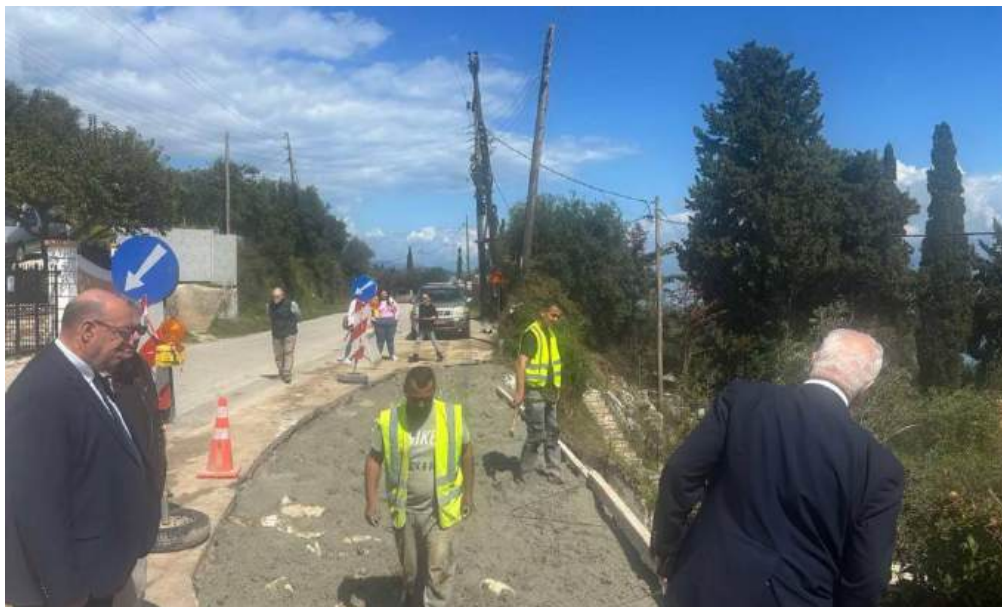
Επιθεώρηση έργων στην περιοχή Τσάκι Μπενιτσών.
