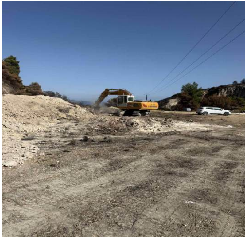
Εργασίες άρσης επικινδυνότητας και αποκατάστασης στην κοινότητα Λιθακιάς, μετά την πυρκαγιά του Αυγούστου 2025, στο πλαίσιο παρεμβάσεων πολιτικής προστασίας και αποκατάστασης του φυσικού και δομημένου περιβάλλοντος.
