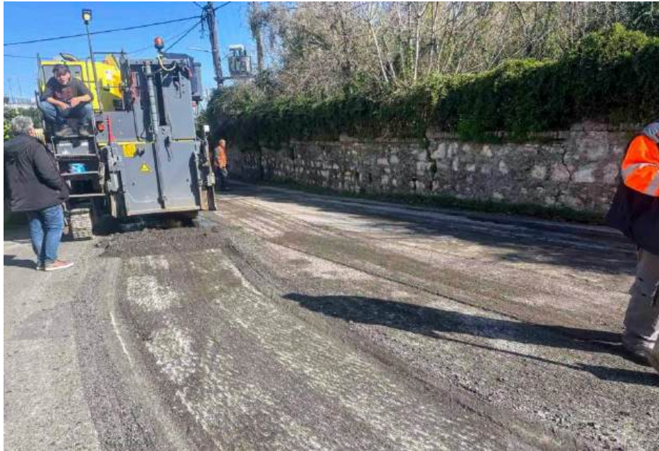
Εργασίες ασφαλτόστρωσης στην περιοχή του Κανονιού, με στόχο την αποκατάσταση φθορών του οδοστρώματος και τη βελτίωση της καθημερινής κυκλοφορίας σε περιοχή αυξημένης χρήσης.
