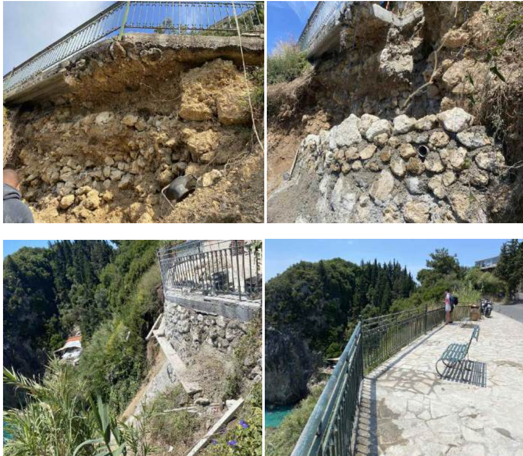
Άμεση τεχνική παρέμβαση αποκατάστασης πρανούς στην περιοχή La Grotta Παλαιοκαστρίτσας, λόγω υποσκαφής και «κούφωσης» βράχου στη βάση του πρανούς, για την άρση συνθηκών επικινδυνότητας και τη διασφάλιση της οδικής και πεζής ασφάλειας.
