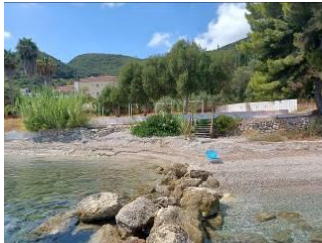
Φώτο 15.8: Άποψη του παραλιακού μετώπου από τον προβλήτα προς τα δυτικά
