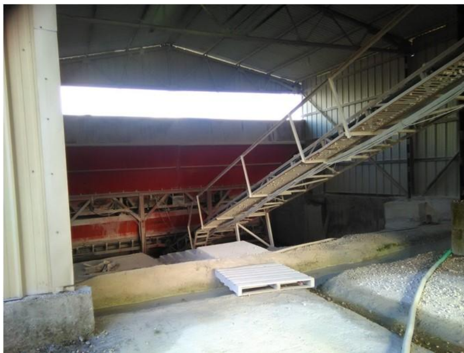
Φ2. ΣΤΕΓΑΣΜΕΝΕΣ ΕΓΚΑΤΑΣΤΑΣΕΙΣ ΖΥΓΙΣΗΣ ΚΑΙ ΜΕΤΑΦΟΡΑΣ – ΚΑΝΑΛΙ ΚΑΘΙΖΗΣΗΣ ΙΛΥΟΣ ΑΠΟ ΤΗΝ ΔΕΞΑΜΕΝΗ ΚΑΘΑΡΙΣΜΟΥ ΤΩΝ ΟΧΗΜΑΤΩΝ
