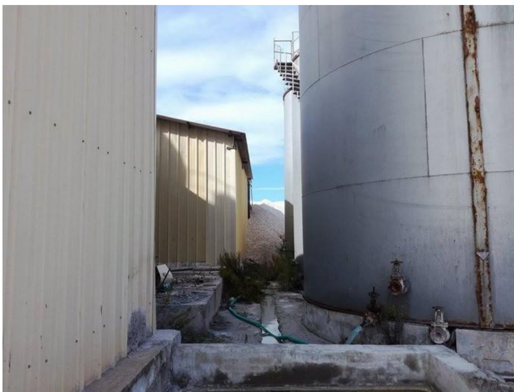
Φ11. ΚΑΝΑΛΙ ΚΑΘΙΖΗΣΗΣ- Καθαρίζεται η λάσπη με φτυάρι και καρότσι.
