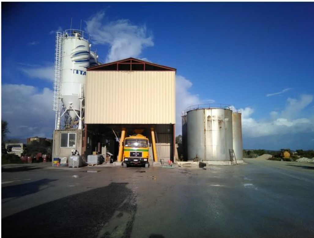
Φ4. ΣΙΛΟ ΤΣΙΜΕΝΤΟΥ ΡΑΜΠΑ ΦΟΡΤΩΣΗΣ ΚΑΙ ΕΦΕΔΡΙΚΕΣ ΔΕΞΑΜΕΝΕΣ ΝΕΡΟΥ
