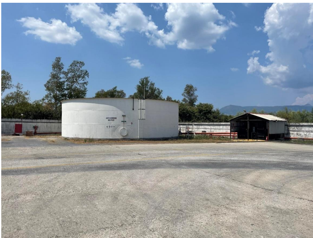
Εικόνα 6.2-1: Άποψη δεξαμενής νερού πυρόσβεσης
