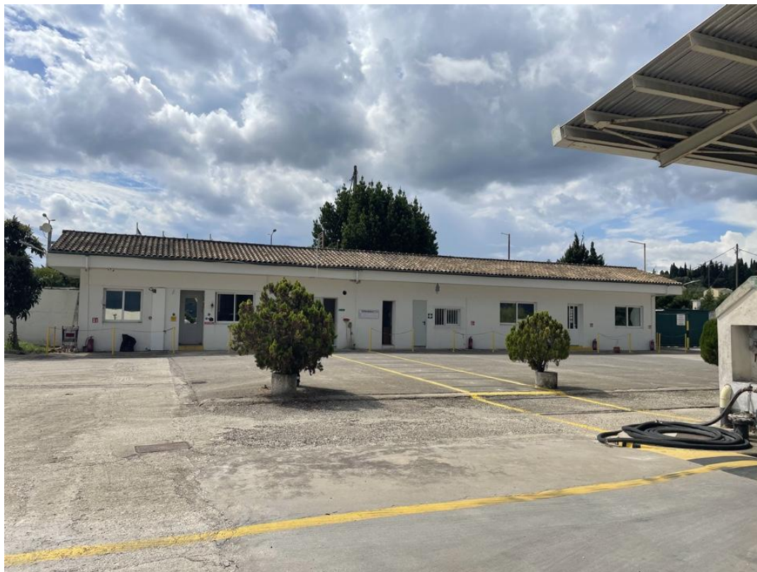
Φωτογραφία 7: Κτίριο Γενικού Ηλεκτρικού Πίνακα
