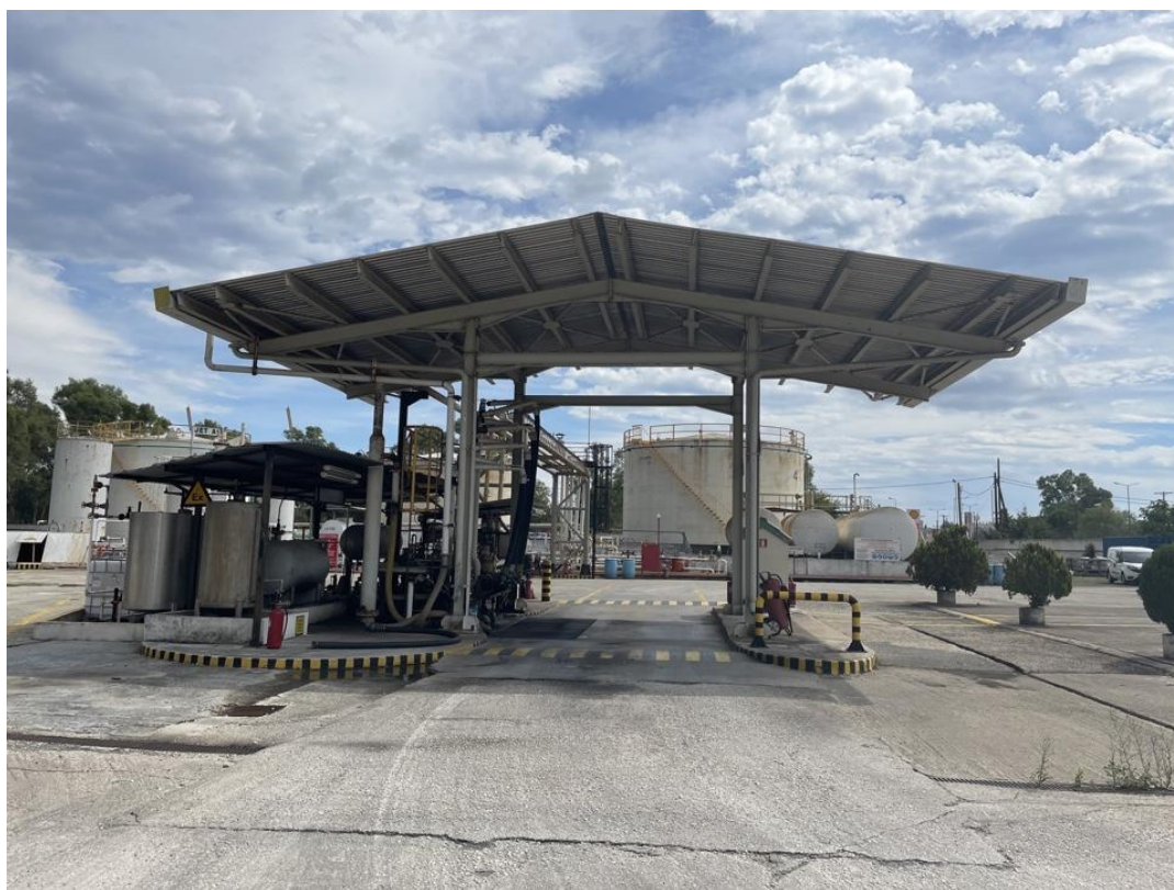
Φωτογραφία 4: Σταθμός φόρτωσης βυτιοφόρων οχημάτων
