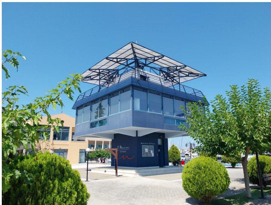
Φωτογραφία 7: Πύργος ελέγχου Μαρίνας Λευκάδας
