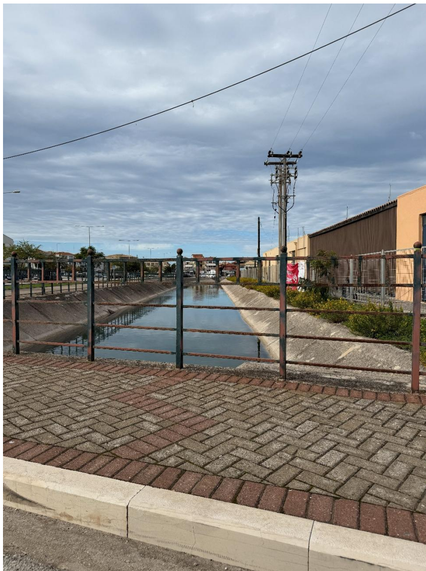
Φωτογραφία 20: Ολοκληρωμένη διαμόρφωση περιοχής μεταξύ του ορίου του χερσαίου χώρου της μαρίνας και της παραλιακής οδού (πεζόδρομος, ποδηλατόδρομος, αντιπλημμυρική διώρυγα, ζώνη πρασίνου).
