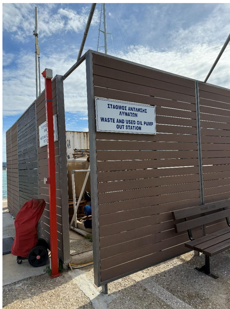
Φωτογραφία 9: Σταθμός απάντλησης λυμάτων στον υπήνεμο μώλο Μαρίνας Λευκάδας.
