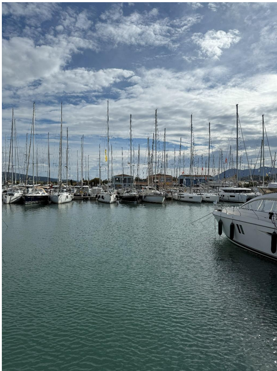
Φωτογραφία 6: Άποψη από θαλάσσης της λιμενολεκάνης της μαρίνας και άλλων κτιριακών εγκαταστάσεων (εστιατόριο, ναυταθλητικές εγκαταστάσεις, κτίριο χερσαίας απόθεσης και συντήρησης σκαφών).
