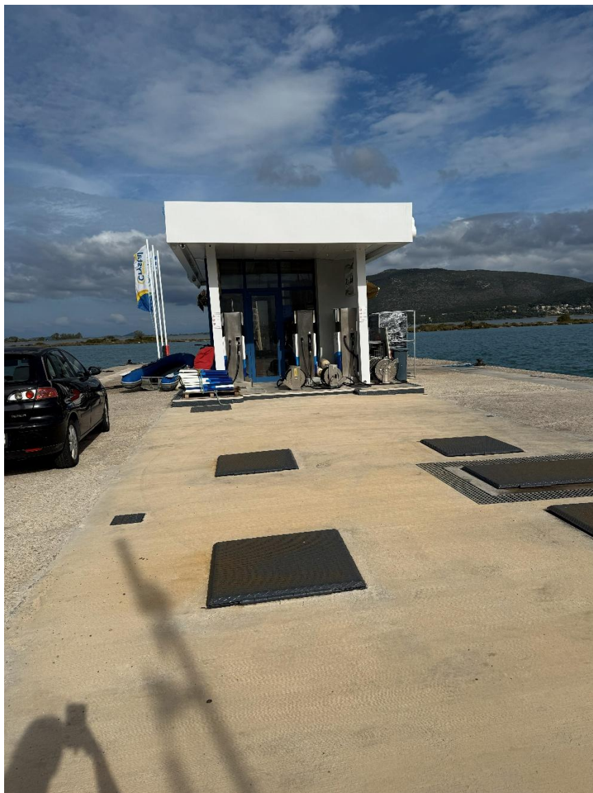
Φωτογραφία 8: Σταθμός καυσίμων στον υπήνεμο μώλο Μαρinas Λευκάδας
