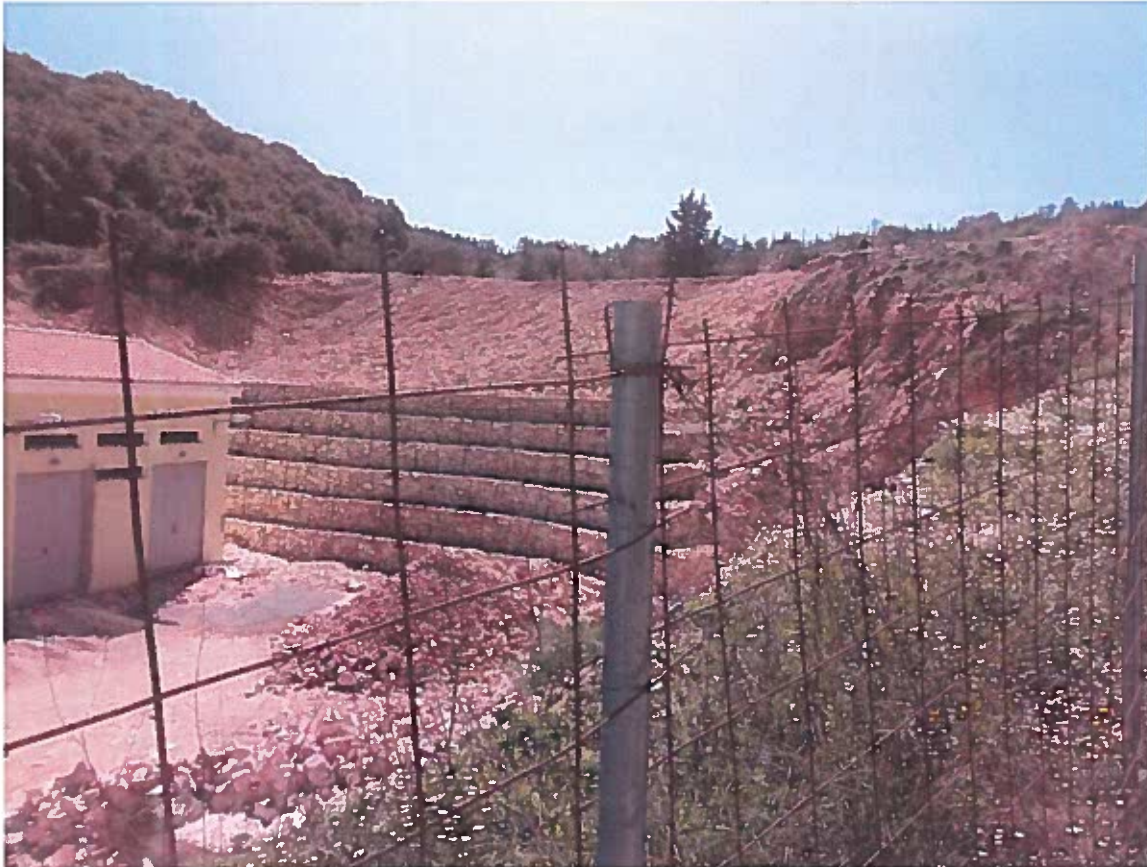
Α.1: Μονάδα Αφαλάτωσης και έργα αντιστήριξης Πρανών
