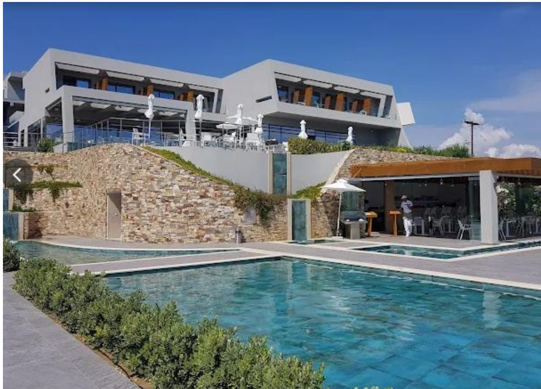
Φωτογραφία 9: Κεντρικό κτίριο.
