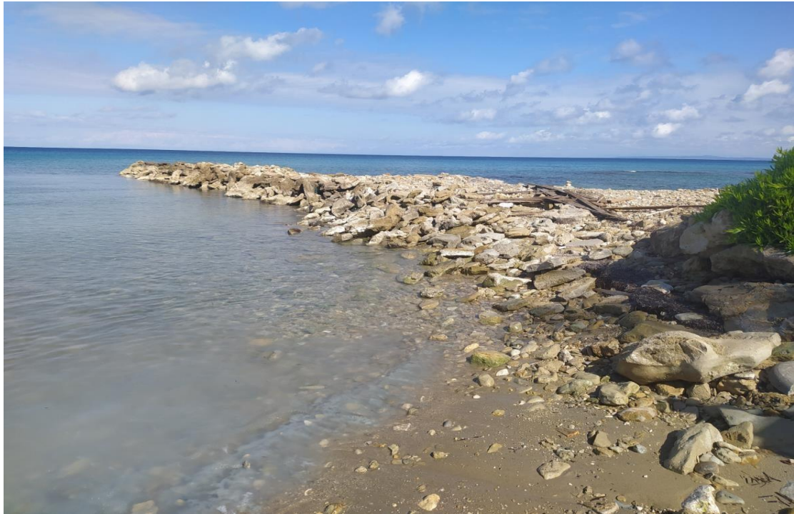
Φωτογραφία 7: Ο πρόχειρος εγκάρσιος πρόβολος από φυσικούς ογκόλιθους και πέτρες στο ανατολικό άκρο της ακτής.
