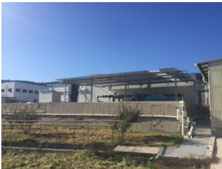
Χώρος νέου κτηρίου για την επεξεργασία του νερού των γεωτρήσεων
